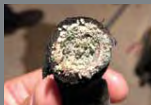
Засорение Y-образного сетчатого фильтра термостатического клапана на распределителе
