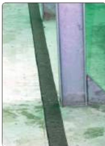
Рисунок 8 – Установка битумных полос
