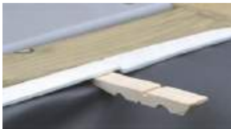
Рисунок 32 – Фиксация лайнера с помощью половинки прищепки
