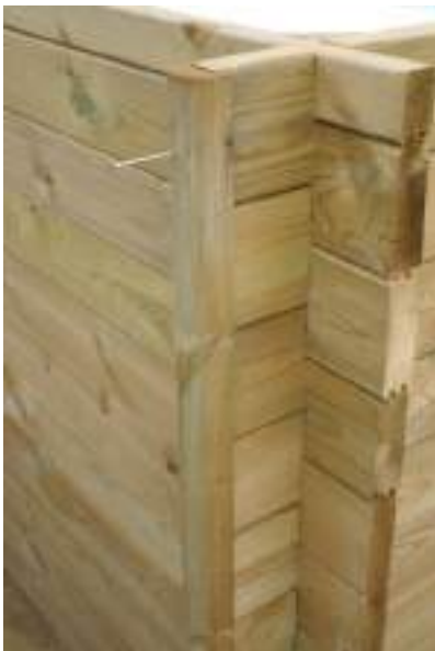
Рисунок 20 – Деревянные накладки
