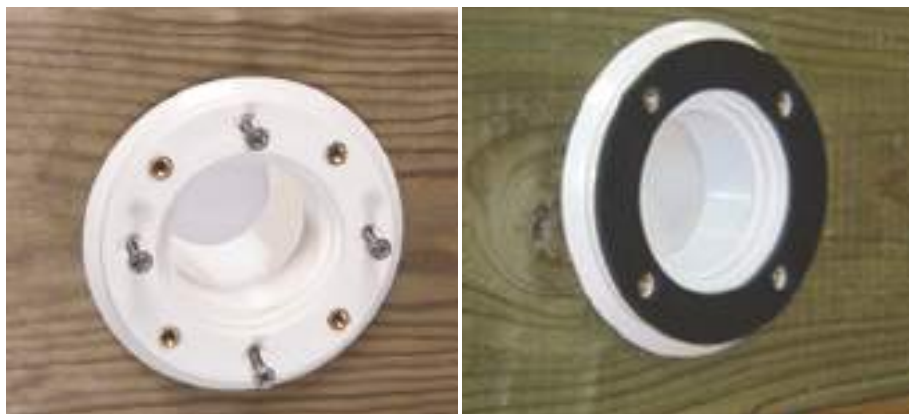
Рисунок 24 – Монтаж корпуса возвратной форсунки и уплотнения
