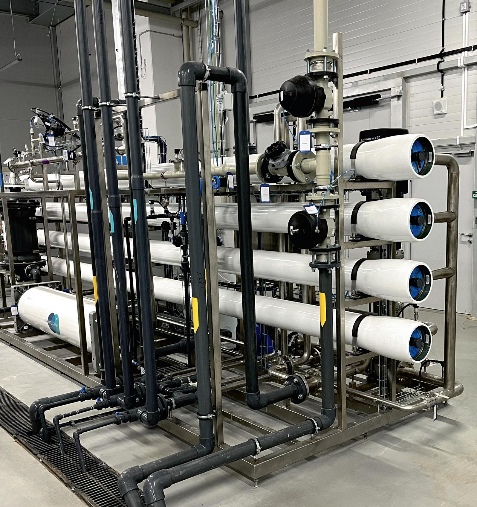
Удельное электрическое сопротивление сверхчистой воды для микроэлектроники до 18,2 МОм·см (деионизованная вода)
