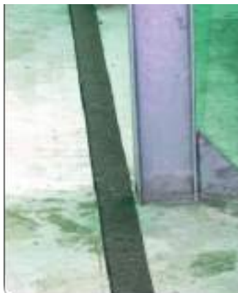
Figure 8 – Установка битумных полос
