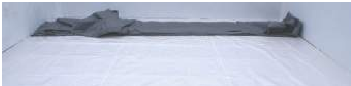
Figure 32 – Разворачивание лайнера
